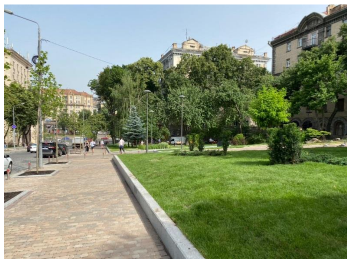
вул. Прорізна після ремонту
