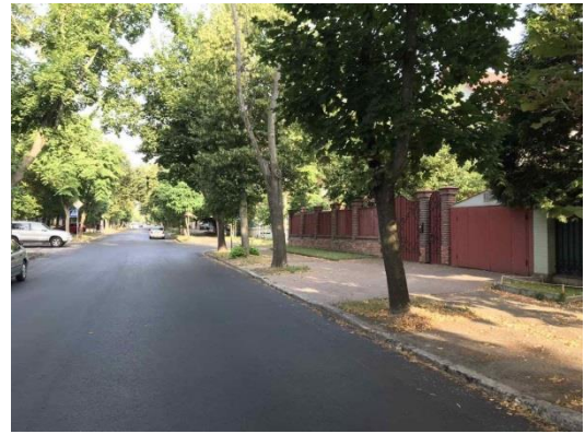
вул. Ружинська після ремонту
